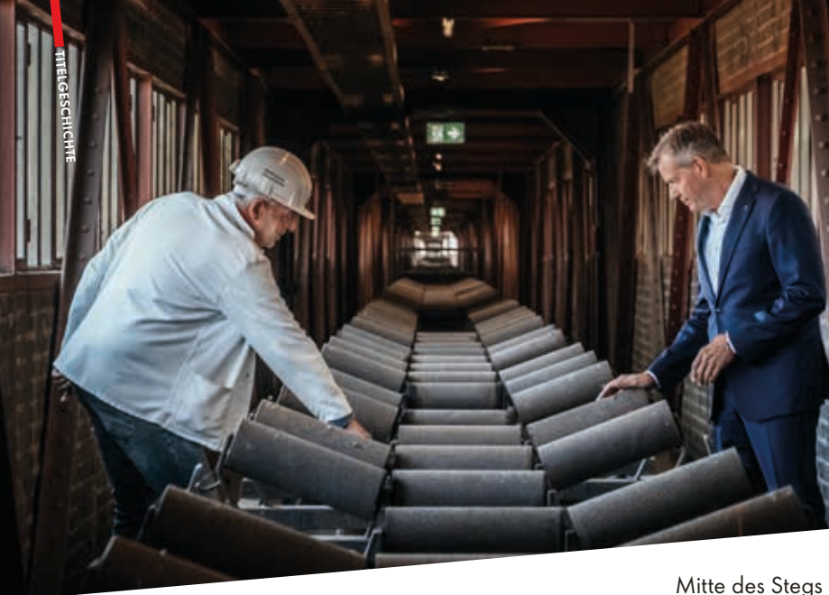
Rund 300 Meter lang ist die einzige Bandbrücke, die die Zeche mit der Kokerei verbindet.
