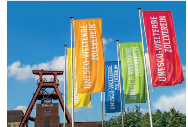
Das berühmte Doppelbock-Fördergerüst auf Schacht XII
