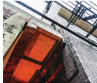
Sanierte und angestrichene Betondecke zwischen Batterie und Kohlenturm 2.
